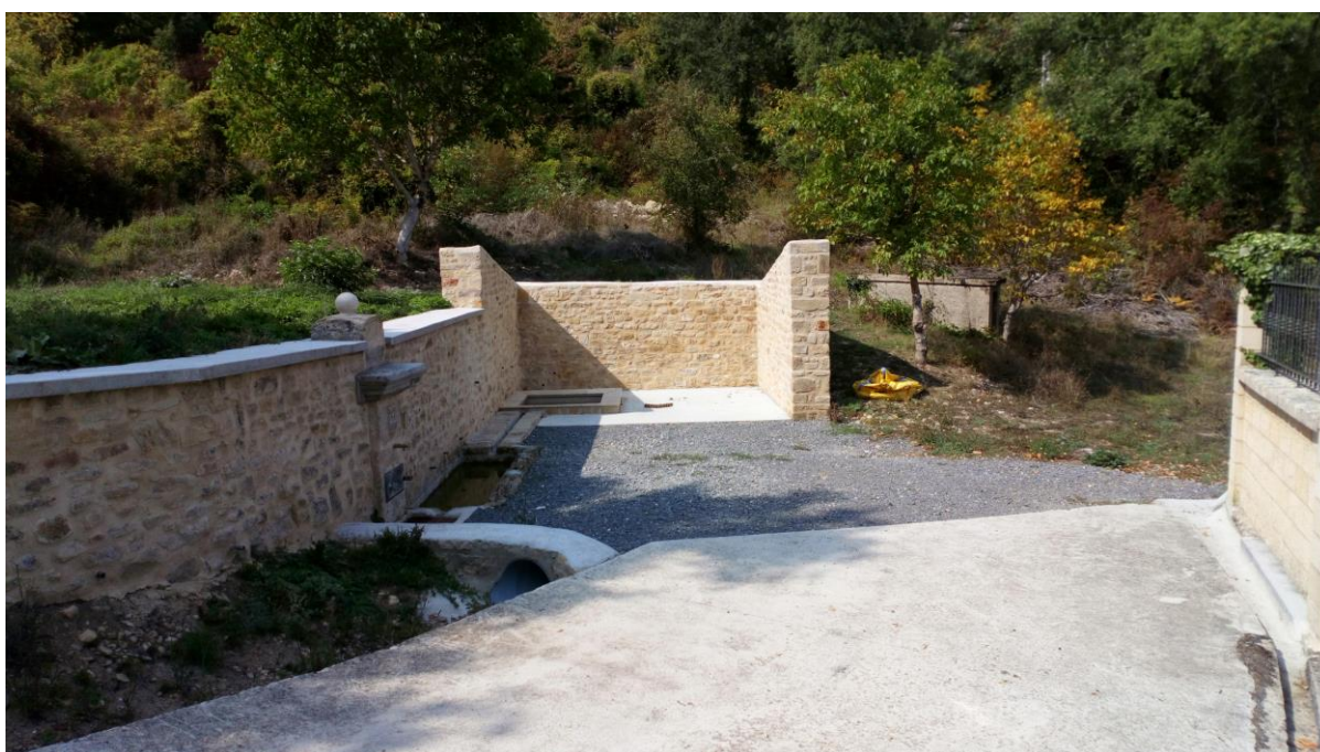
Foto 2 – Estado actual del conjunto
